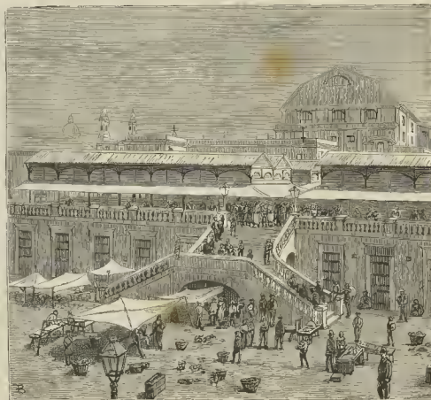
INTERIOR DEL MERCADO CENTRAL
